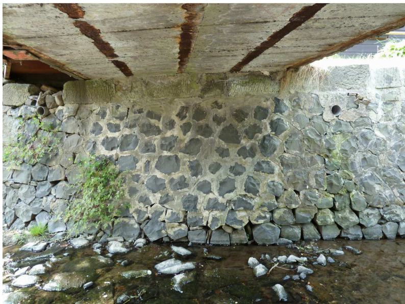
Podhled nosné konstrukce a pravá opěra
