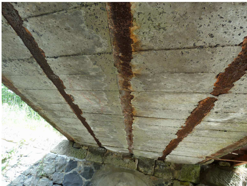
Podhled nosné konstrukce, stopy po zatékání, koroze ocelových profilů
