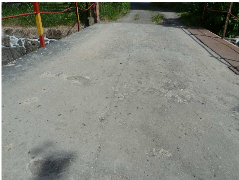
Podélná trhlina v nosné konstrukci
